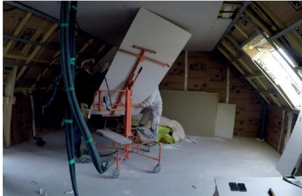
▲ Chantier 3 - Inadéquation du lève-plaque avec la configuration des rampants
