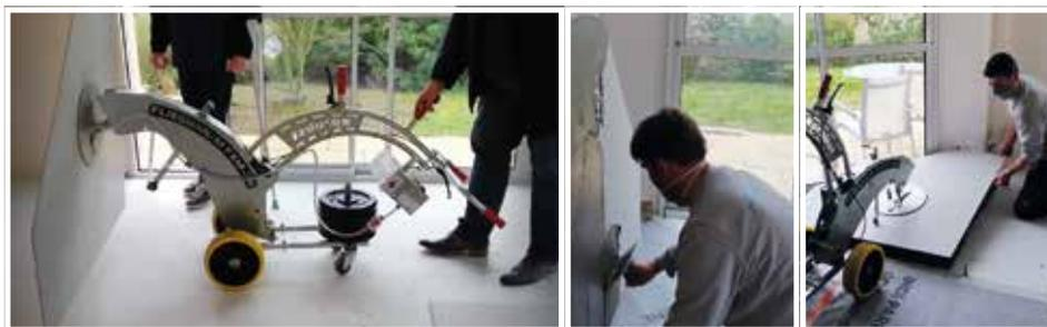
▲ Photos 13 – Chantier 3 – Expérimentation Fliegman FXM-30 – Ventousage, encollage et pose
