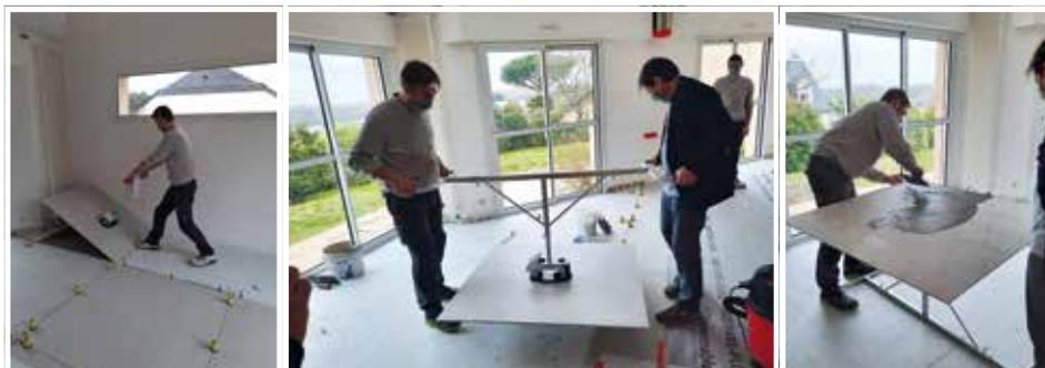
▲ Photos 14 – Chantier 3 – Expérimentation Flieguan Accu Handy FXAH-120 Grabo Green et accessoires – Déplacement et pose
