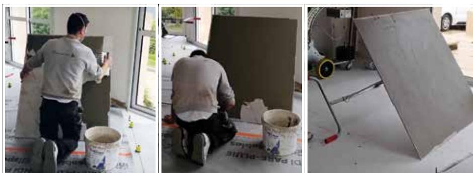
▲ Photos 15 – Chantier 3 – Encollage carreau au sol (support poignée simple ou double)
