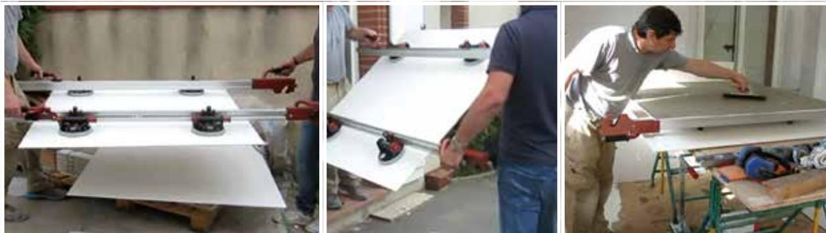
▲ Photos 21 – Chantier 5 – Expérimentation Easy Move 150 – Déplacement et encollage
