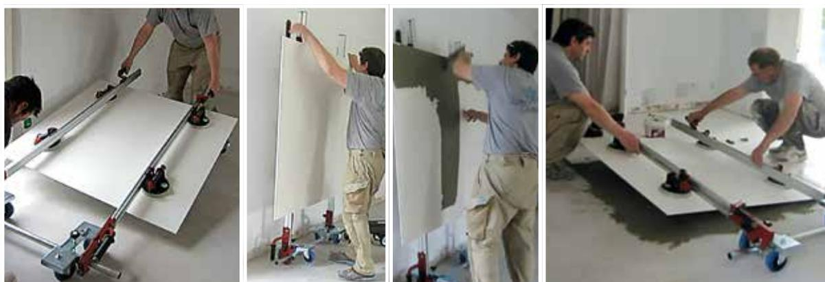
▲ Photos 22 – Chantier 5 – Expérimentation Only One – Déplacement, encollage et pose
