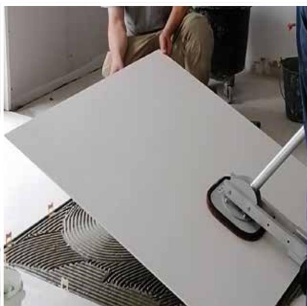
▲ Photo 17 – Chantier 5 – Expérimentation Flieguan-Ergo-Stick FXES-25 – Déplacement et pose
