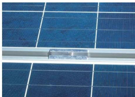
Fig. 4 - Cellules photovoltaïques en silicium multicristallin
