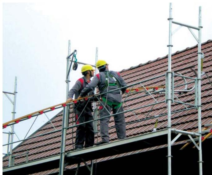
Fig. 16 - Protections collectives en bas de pente
