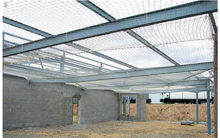
Fig. 19 - Filets en sous-face
