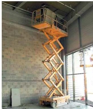
Fig. 22 - Installation industrielle en réhabilitation à l'aide de PEMP
