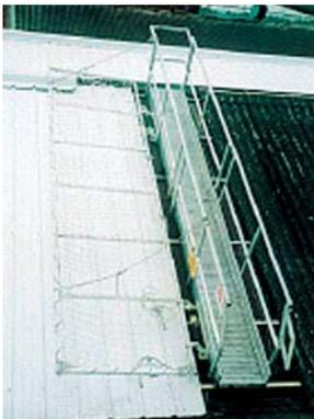
Fig. 21 - Installation industrielle neuve à l'aide de train de pose
