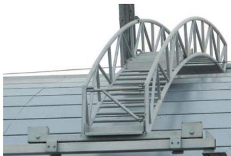
Fig. 11 - Exemple de passerelle mobile d'entretien
